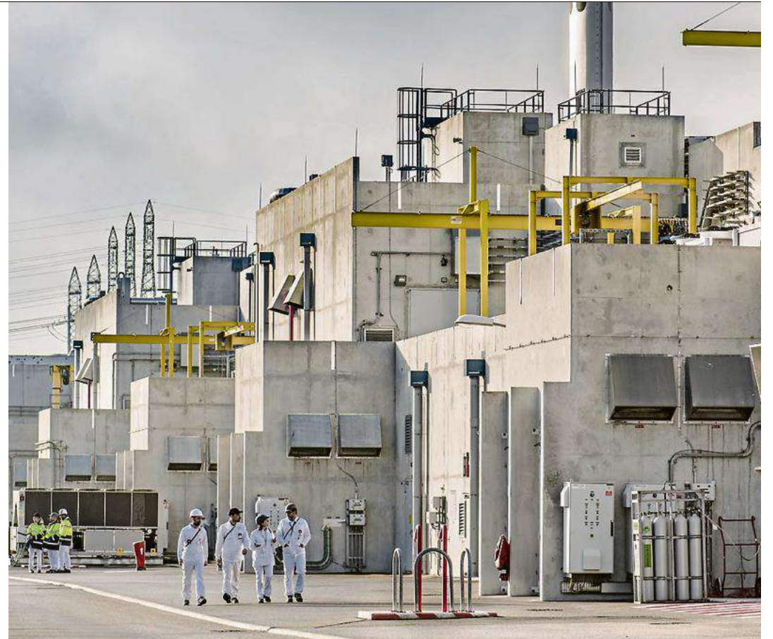
Au total, 300 à 500 salariés devraient être mobilisés sur le chantier, puis une cinquantaine pour exploiter le site après les travaux. Photo Eric Larrayad/Orano
